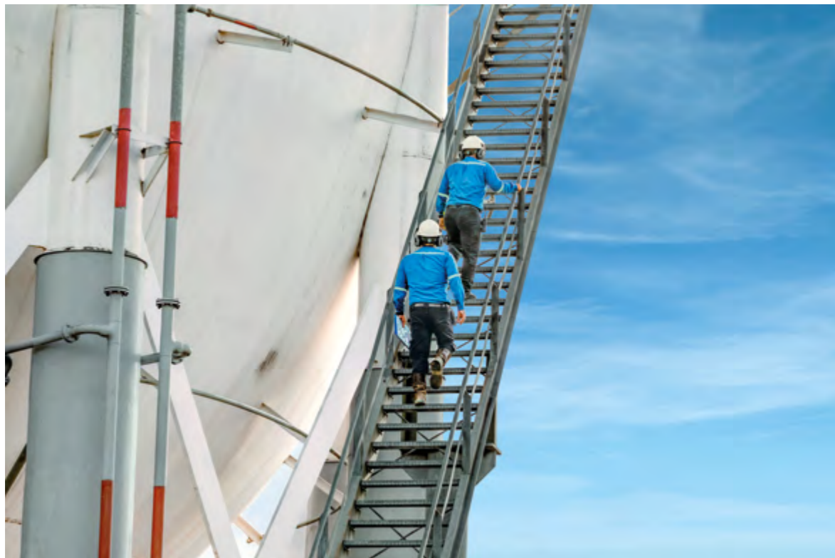
Malvinas Plant, Camisea. Peru
